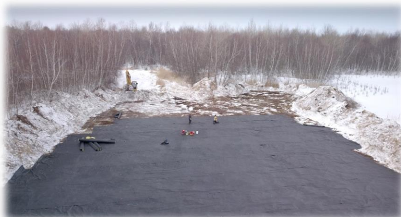
Déploiement de la membrane géotextile au boisé des Terres noires en mars 2019 © FCEL
