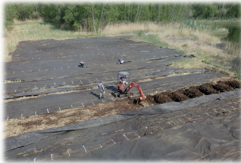
Aménagement des butons de plantation dans la membrane géotextile en mai 2020, boisé des Terres noires © FCEL
